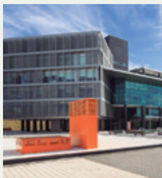
Tehnološki park u Andaluziji. Kancelarije visoke energetske efikasnosti. Španija. ECOi
