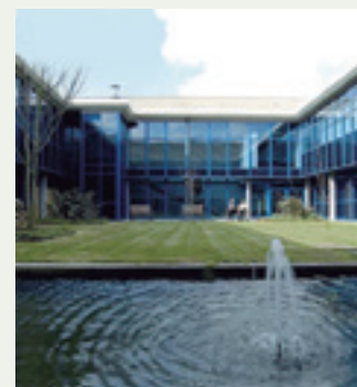
NHS Canford kućna klinika, Bournemouth, UK. VRF
